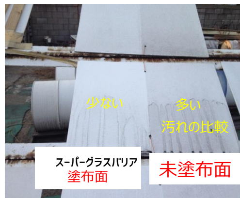
汚れにより赤外線反射率低下
